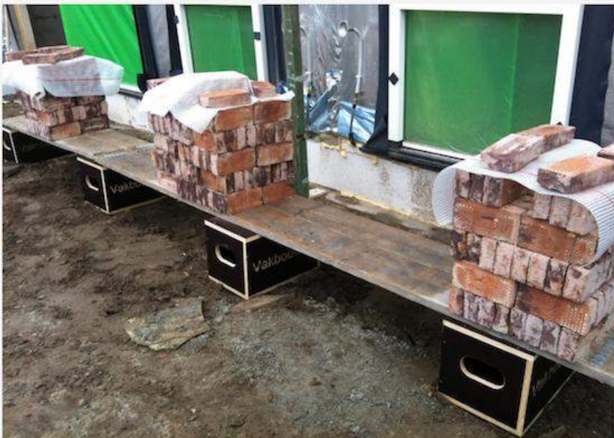
In 2012 zijn de eerste opperkistjes in het zaag- en freescentrum van VM Geveltechniek gemaakt. Een mooi stukje reclame op de bouwplaatsen.
