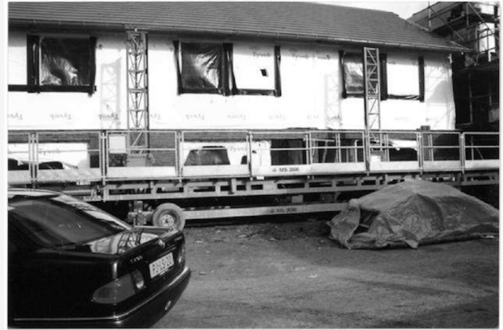
De opdrachten worden steeds groter en midden jaren 70 wordt er geïnvesteerd in de eerste hefsteiger.
