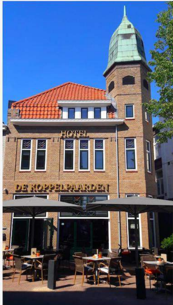
Rond de bouwvak van 2017 is Wessels gestart met het verbouwen van hotel / café 'De Koppelpaarden' te Lichtenvoorde. In opdracht van de 'Zeven Belegen Beleggers', waaronder Theo en Nico Wessels.
