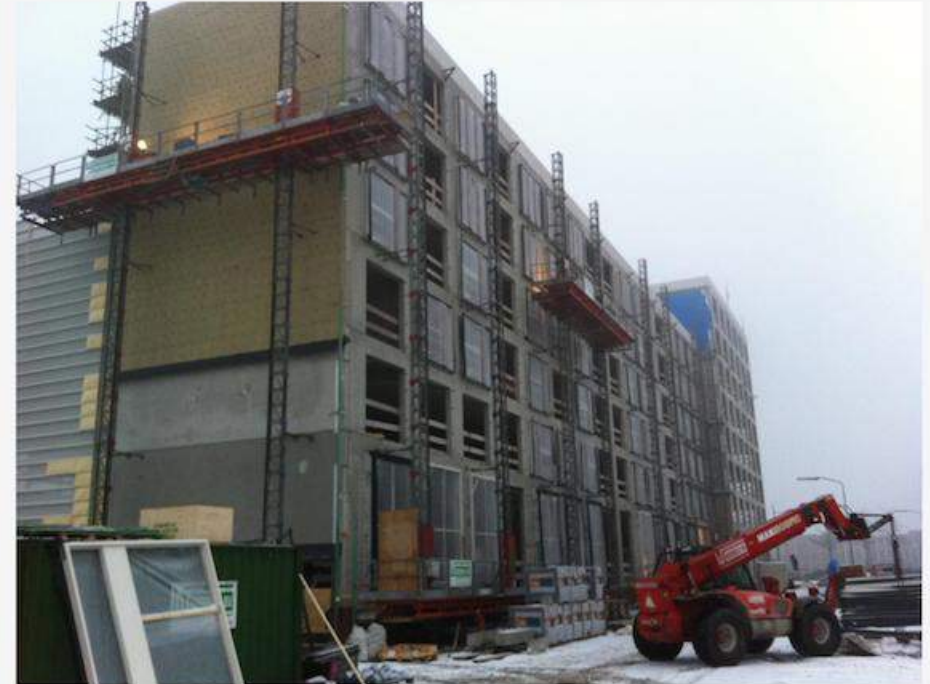
Ondanks het koude winterweer in februari 2013, wordt er gewoon doorgewerkt op de heftsteigers in Helmond.
