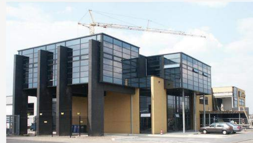
Kantoorpand Dusseldorp Lichtenvoorde
